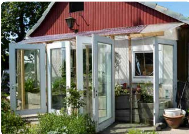
(Abbildung: Anlehnengewächshaus aus Glastüren) Anlehnengewächshaus aus recycelten Glastüren mit Hochbeeten, die zur Anzucht im Frühjahr geeignet sind
